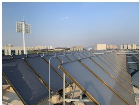
使用过程平板式太阳能热水器为顶水方式工作，真空管太阳能热水器也可实行顶水工作的方式，水箱内可以采用夹套或盘管方式。顶水工作的优点是供水压力为自来水压力，比自然重力式压力大，尤其是安装高度不高时，其特点是使用过程中水温先高后低，容易掌握，使用者容易适应，但是要求自来水保持供水能力。顶水工作方式的太阳能热水器比重力式热水器成本大，价格高。1. 温差控制集热循环太阳能热水地暖系统中有集热器温测器和水温感应器，集热系统吸收太阳能辐射后，集热管温度上升，当集热器温度和水箱温度水温差 $\Delta t$ 设定值时，检测系统发出指令，循环泵将中央热水器中的冷水输入集热器中，水被加热后再回到水箱中，使水箱内的水达到设定的温度。2. 地暖管道循环系统增加一台热水循环泵，通过控制器控制地暖管道循环。当水温达到设定温度时，自动启动地暖循环泵，使高温水通过地暖盘管在室内循环，从而使室内温度不断提高。当水箱水温低于某一设定值时，自动停止地暖管道循环泵。
